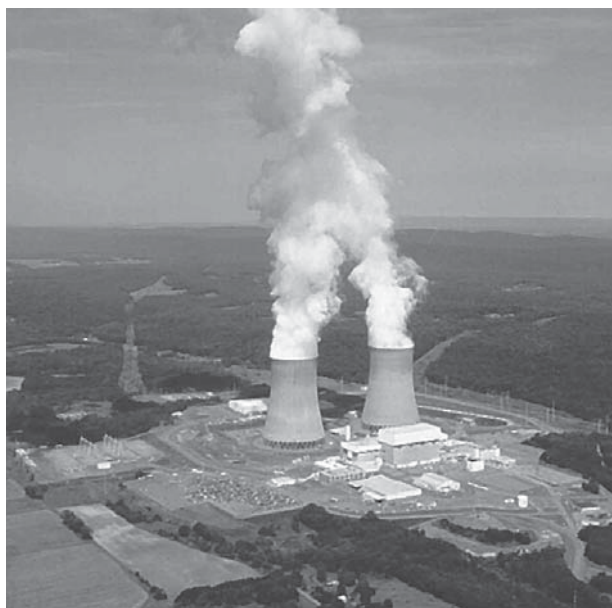
Elektrownia jądrowa w Pensylwanii, USA
