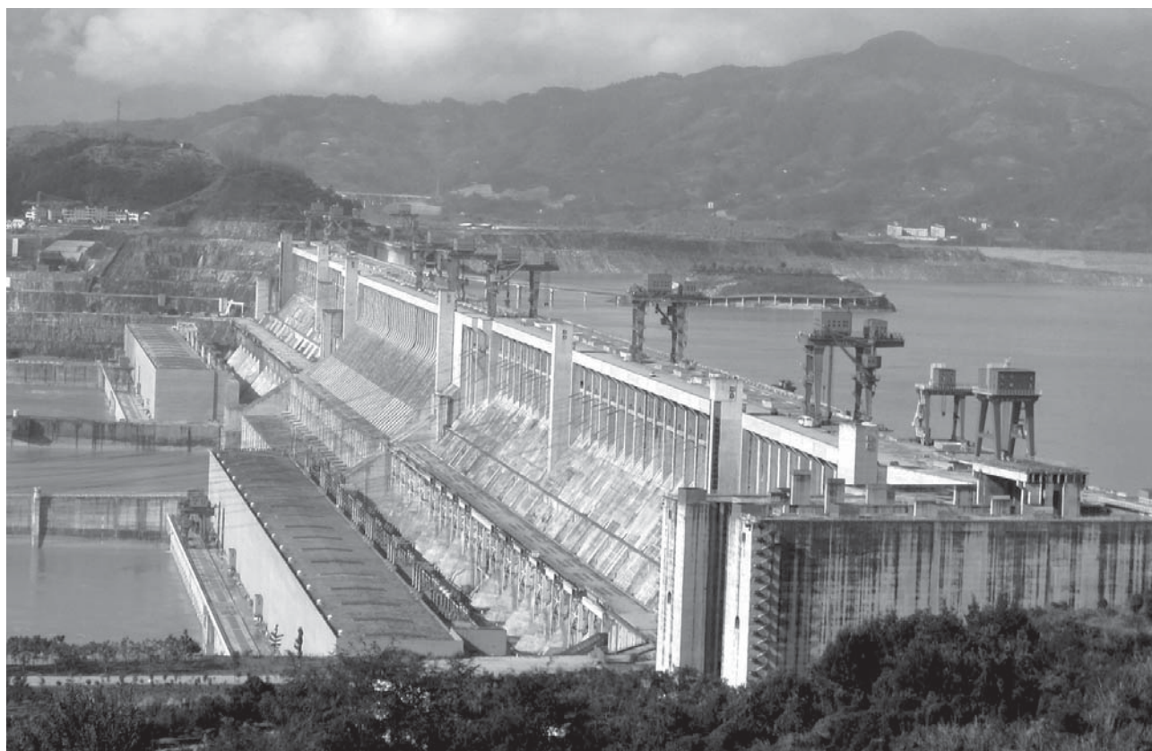
Elektrownia wodna w Chinach
