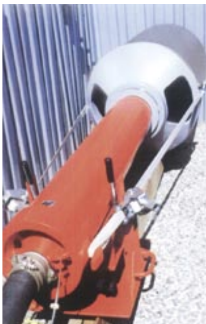
Rys. 3. Wbijanie rur stalowych. Na pierwszym planie przebijak pneumatyczny umieszczony w łożu, na drugim planie pierścienie pośrednie (stożki redukcyjne), adapter, wbijana rura stalowa [3]
