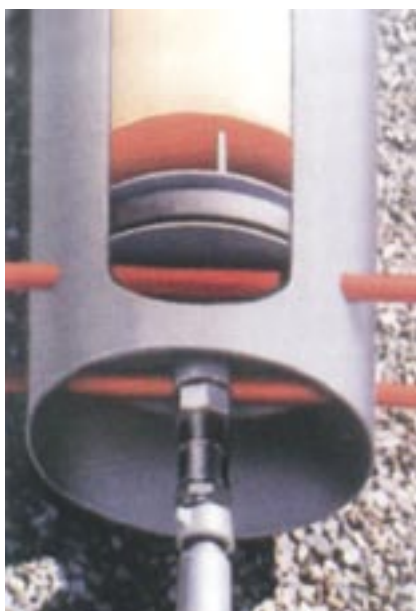
Rys. 6. Przekrój przez koniec rury stalowej z widocznym korkiem poliuretanowym, płytą stalową wraz z uszczelką pierścieniową oraz blokującymi prętami stalowymi [3]
