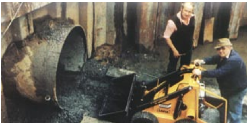
Rys. 4. Usuwanie urobku z wnętrza rury miniatadowarką [3]
