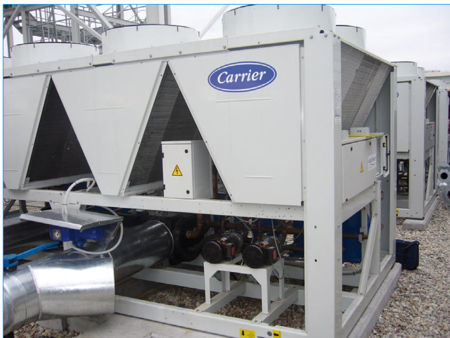
Rys. 5. Agregat 30RB AQUASNAP PURON wyposażony w opcję free-cooling
